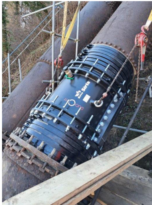
Foto 1 – Intervento in corrispondenza di un giunto di dilatazione
